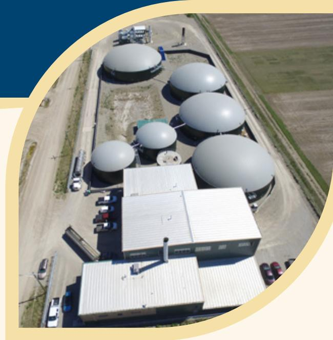
C'est ainsi qu'en 2024, Skyline Clean Energy Fund a terminé la mise en place d'un système novateur de déconditionnement dans sa centrale de biogaz à Lethbridge (Alberta). Le système permet à la centrale de transformer efficacement les déchets organiques résidentiels triés à la source et les déchets de la fabrication d'aliments en gaz naturel renouvelable (GNR). Il sépare et transforme efficacement les matières organiques et traite les emballages en tout respect de l'environnement.
