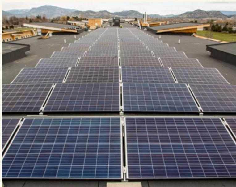
Sur le toit du complexe Carrington View se trouve une installation solaire primée<sup>3</sup>, qui produit de l'énergie propre pour les appartements et les aires communes. Toute l'électricité excédentaire est réinjectée dans le réseau de BC Hydro dans le cadre du programme d'autoproduction. Cette installation solaire sur le toit rehausse la valeur de la propriété et réduit les coûts d'électricité dans les aires communes, ce qui contribue à augmenter la valeur pour les parties prenantes.
